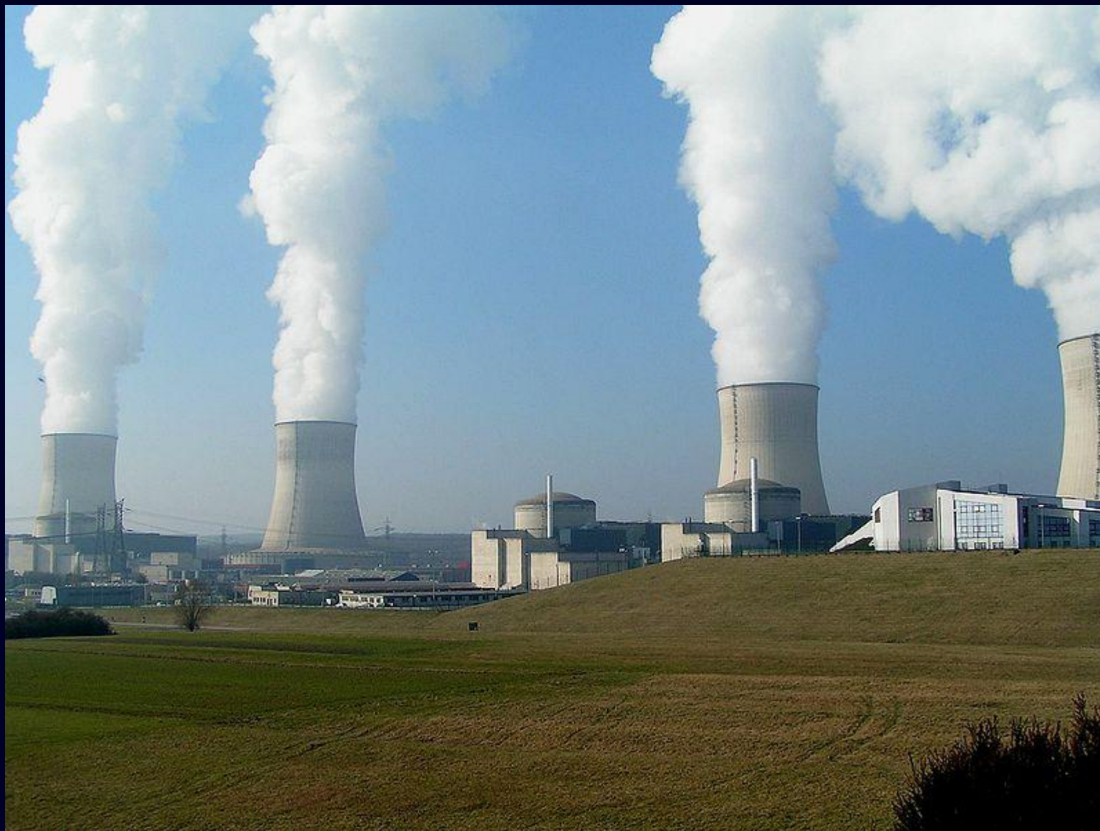
ELEKTROWNIA JĄDROWA - CATTENOM (FRANCJA)
